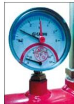
Термоманометр на выходе котла
