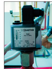
Реле максимального давления воды
