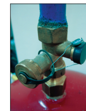
Многофункциональная арматура для расширительного бака
